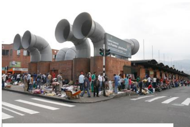
Fotografía 8 Bazar de los Puentes
