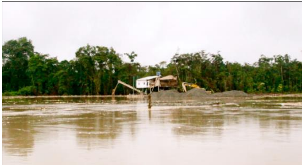
Figura 6. Remoción de arena en el lecho del Rio Quito 2016
