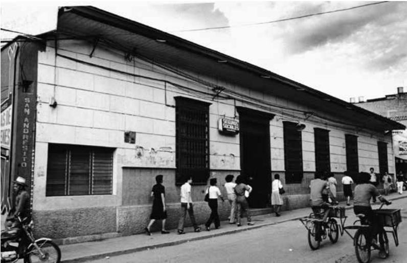
CASA DE LA CALLE DE BOYACÁ, SEDE DEL LICEO DE BACHILLERATO DE LA UNAULA
