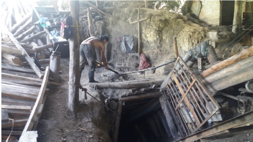
Fotografía N°5, Mina de carbón en Angelópolis, Vereda El Barro Fotografía tomada por la estudiante en trabajo de campo, abril de 2016.
