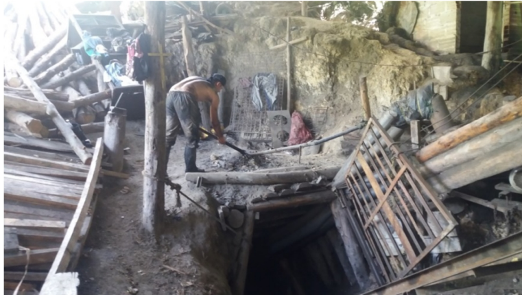
Fotografía N°10, Mina de carbón en Angelópolis, Vereda El Barro Fotografía tomada por la estudiante en trabajo de campo, abril de 2016.
