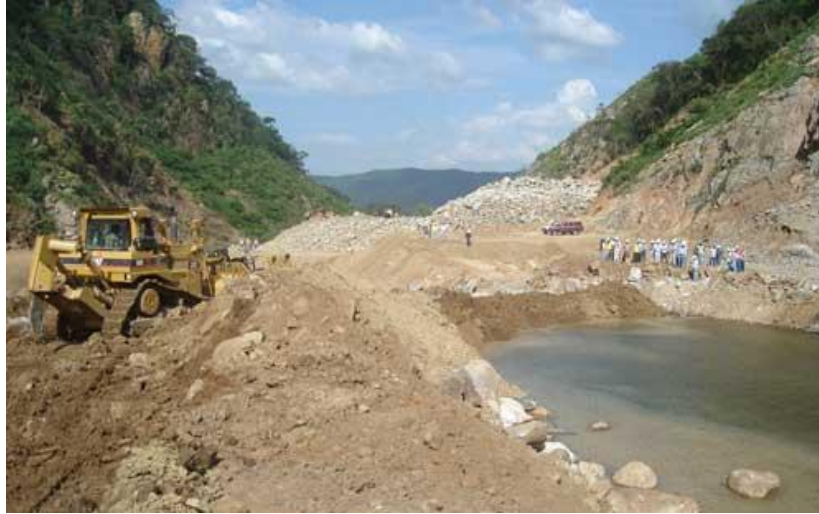
Fotografía 1. Obras para el desvío del río Ranchería
