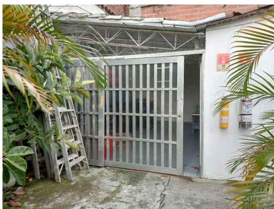
Gráfico 111. Cuarto de selección de residuos, edificio Santa Inés.
