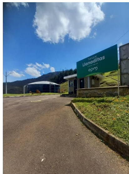
Figura 14 Tanque de EPM – Llanaditas
