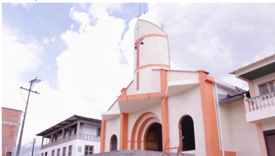
Figura 3: Iglesia reconstruida después de la toma guerrillera en el Corregimiento de Arboleda, Pensilvania – Caldas.
